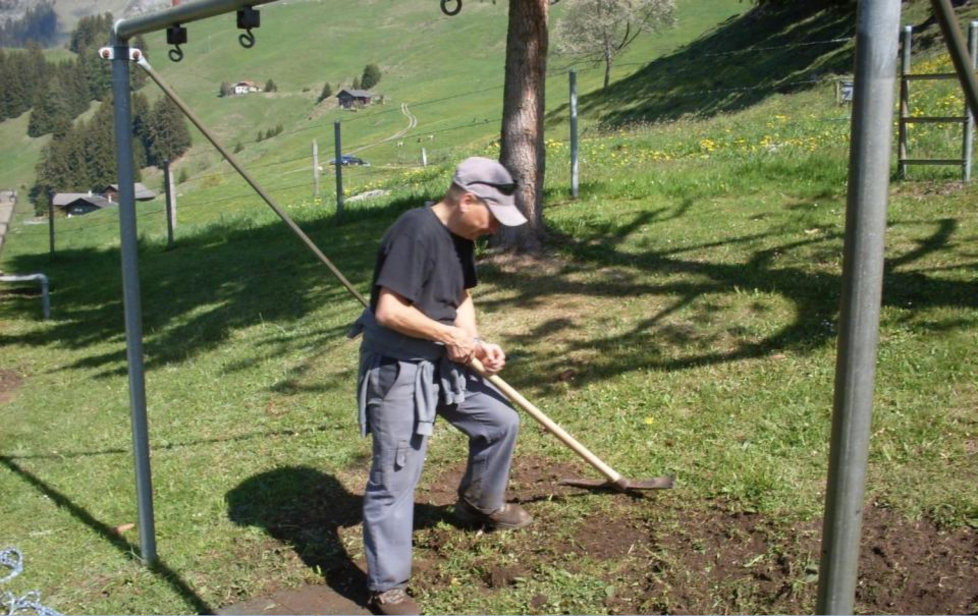
Travaux autour du chalet
