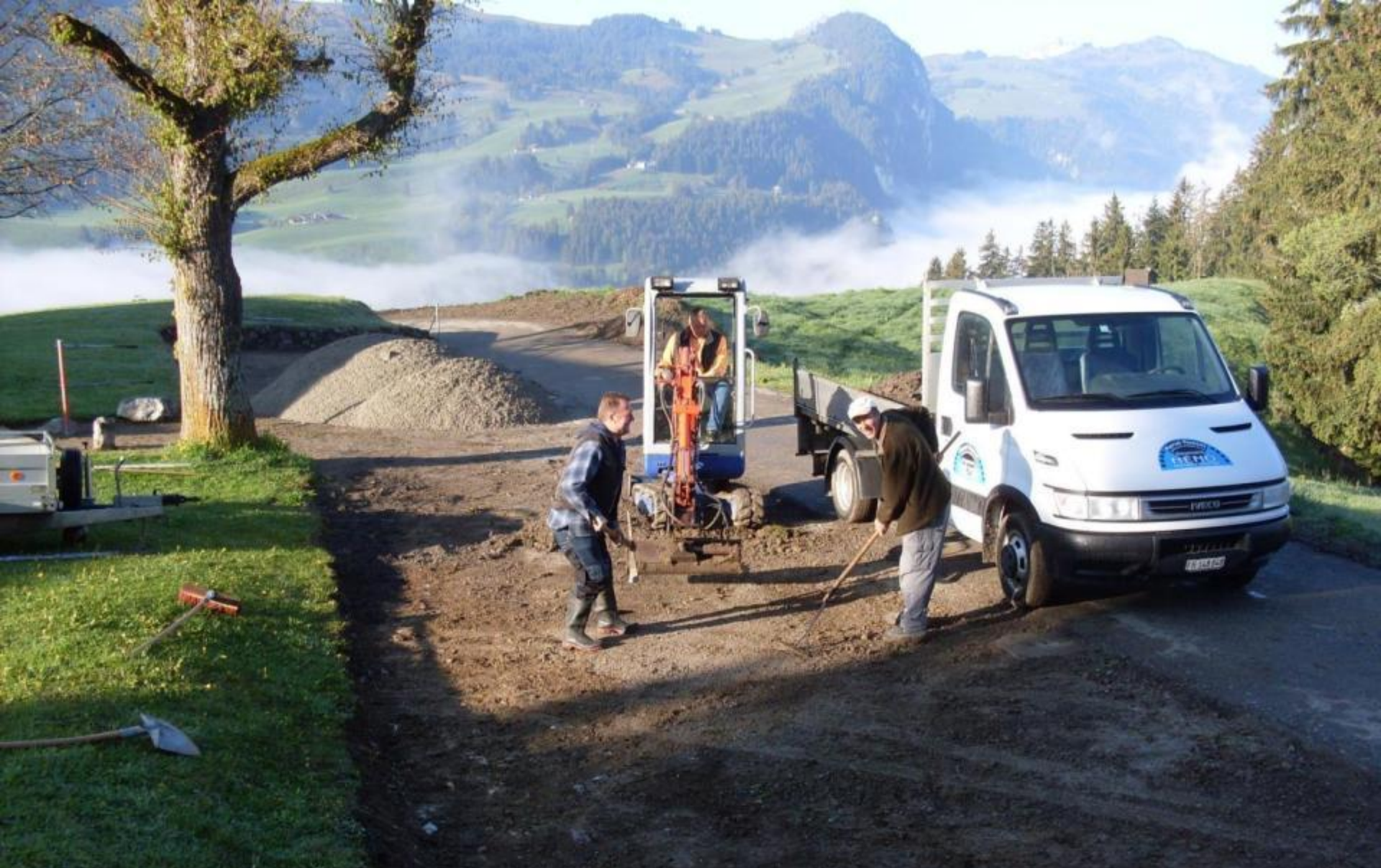
Travaux de la place de parc
